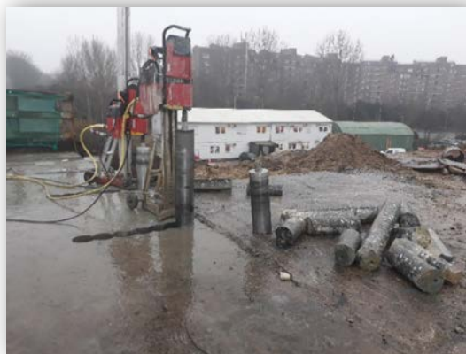
Foto-17 Doorboren einddwarsdrager
